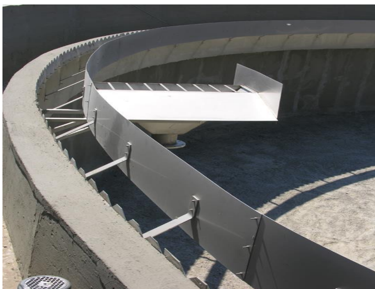
Εικόνα 6: Μονάδα πρωτοβάθμιας καθίζησης με κινητή γέφυρα
