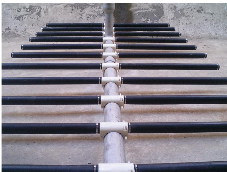
Εικόνα 7: Σωληνοειδείς διαχυτήρες λεπτής φυσαλίδας
