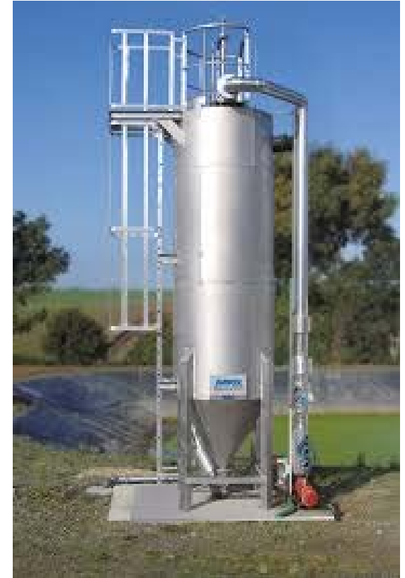
Αυτοκαθαριζόμενο αμμόφιλτρο ανοδικής ροής
