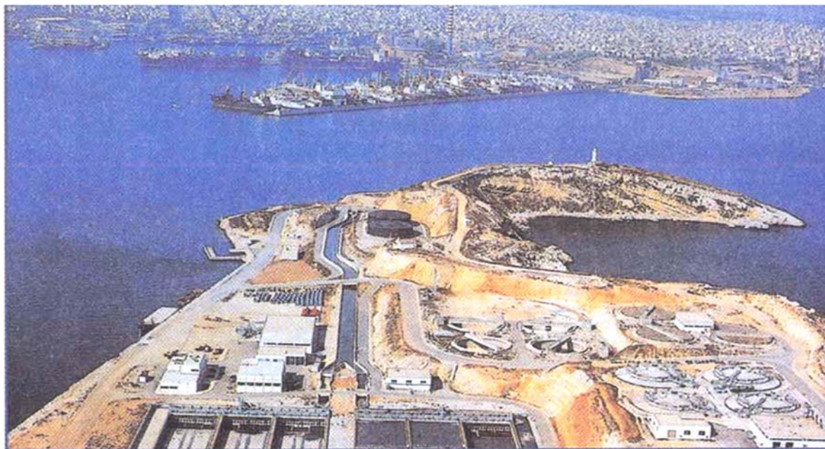
Πανοραμική άποψη των εγκαταστάσεων βιολογικού καθαρισμού στη νήσο Ψυτάλλεια
