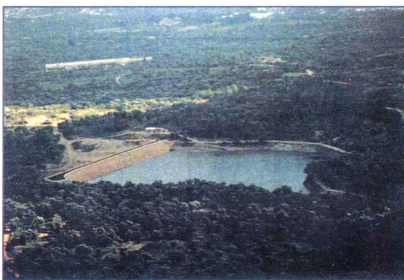
Φράγμα στη θέση Ζυφιά της νήσου Χίου
