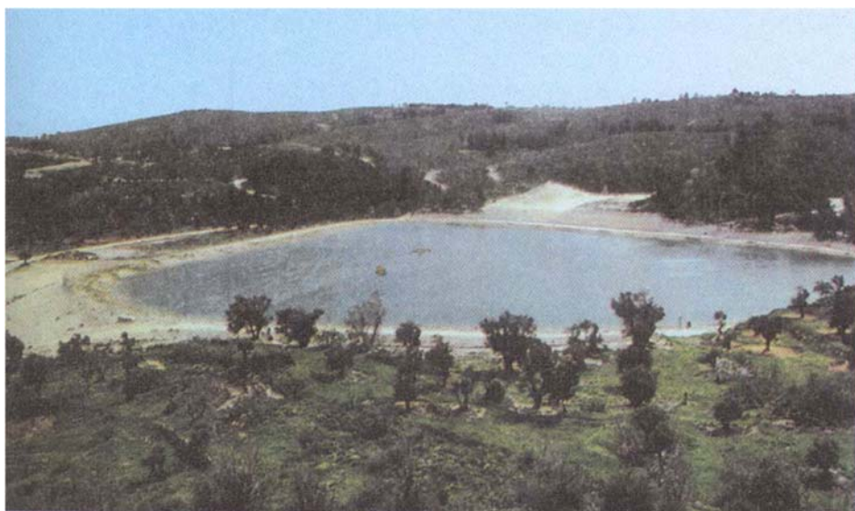
Κάτω: Η λιμνοδεξαμενή Μυτηλινιών με χωρητικότητα 150.000\text{ m}^3 νερό.
