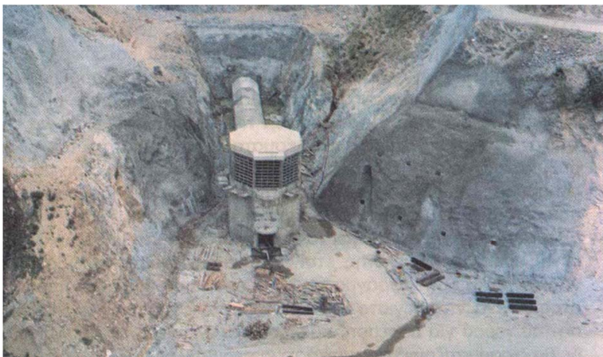
Το έργο υδροληψίας (στο στάδιο κατασκευής του, 1998-99) για την άρδευση της πεδιάδας Δράμας, εντός του ταμιευτήρα «Πλατανόβρυση» στον ποταμό Νέστο.
