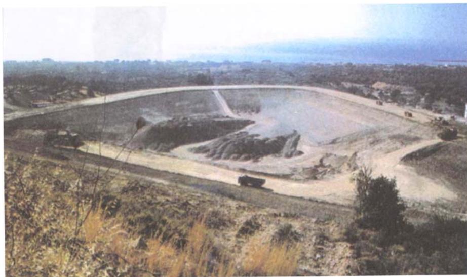
Επάνω: Η λιμνοδεξαμενή Μαραθόκαμπον , κατά το στάδιο της κατασκευής της, με προβλεπόμενη χωρητικότητα 325.000\text{ m}^3 νερό.
