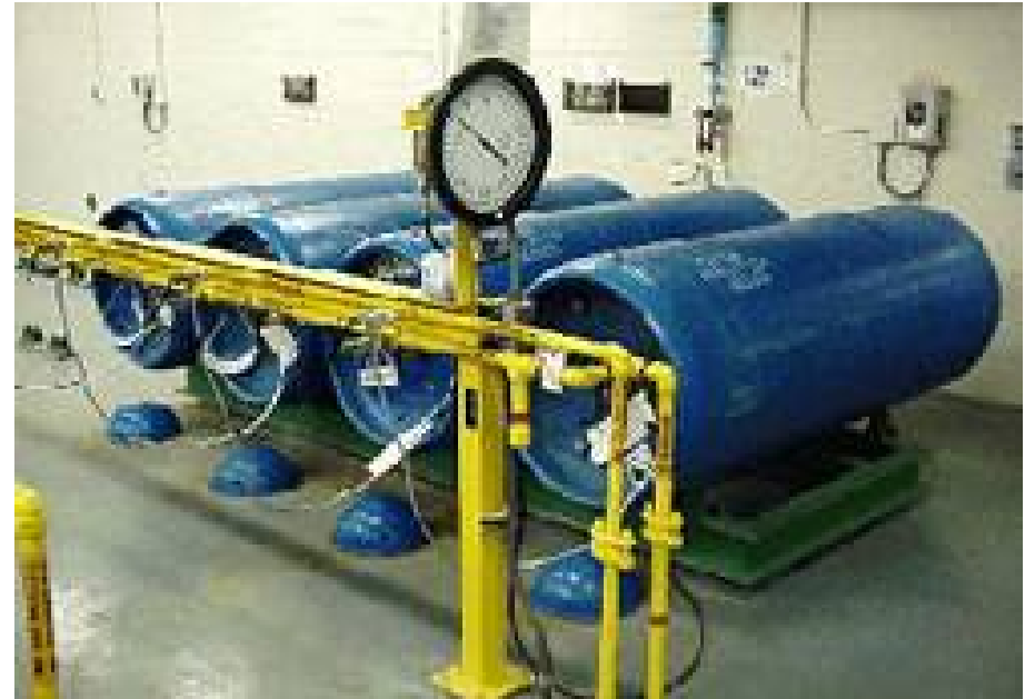
Δεξαμενές θειοθεικού νατρίου
