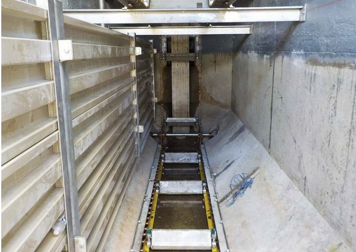
Σύστημα ανελκυστήρα με κουβάδες
