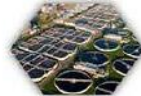
Επεξεργασία υγρών αποβλήτων
