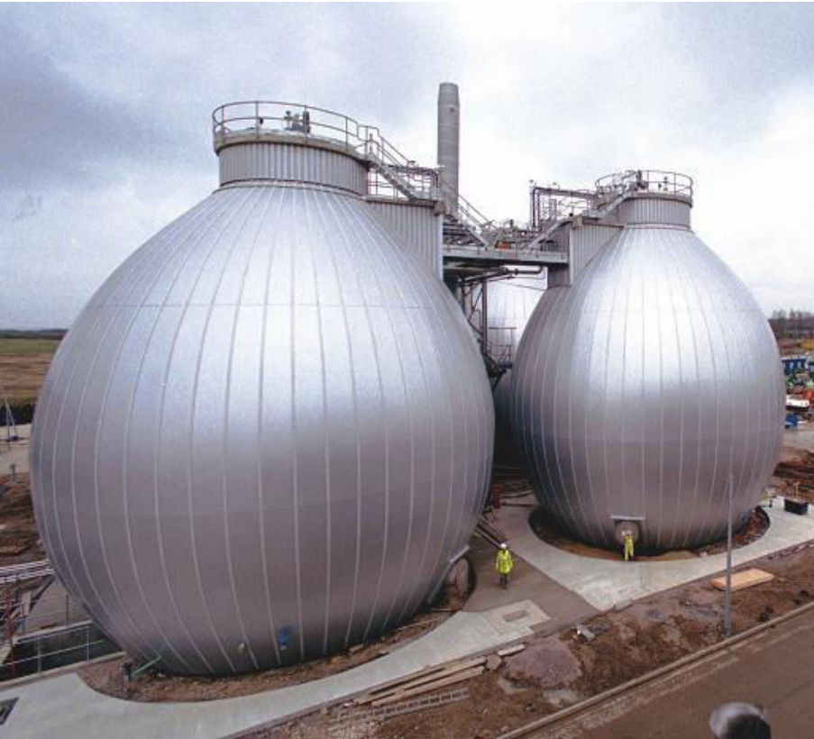
Χωνευτές σε σχήμα αυγού Egg-shaped digesters
