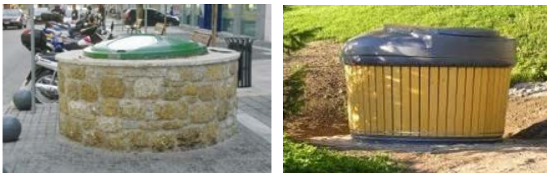
Εικόνα 2.5: Παραδείγματα ημιυπόγειων κάδων.
