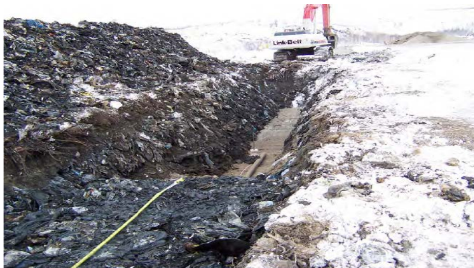
Εικόνα 6.4: Τοποθέτηση οριζόντιων αγωγών συλλογής βιοαερίου [CRA, 2010].
