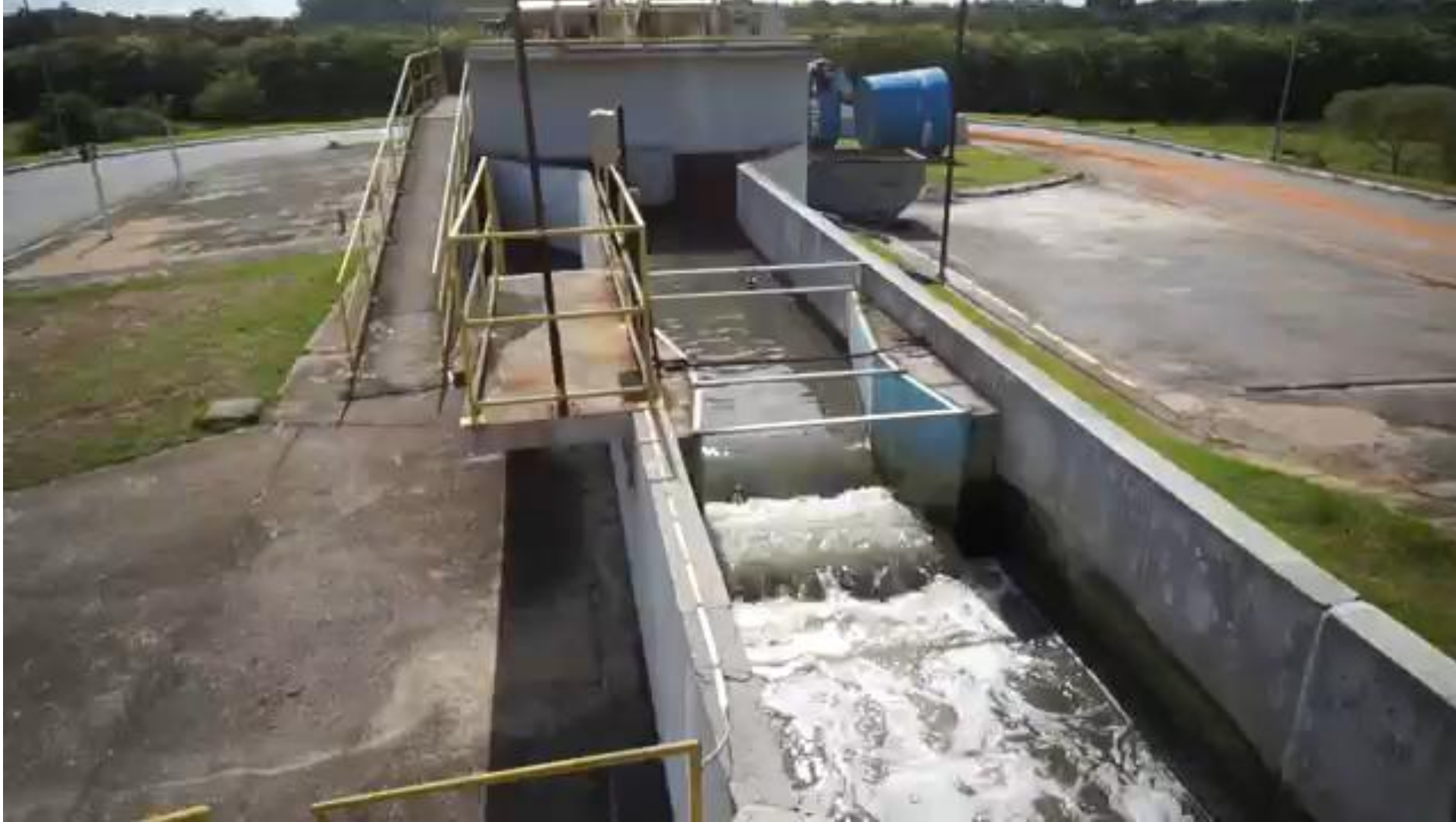
Video αεριζόμενου αμμοσυλλέκτη σε ΕΕΛ
