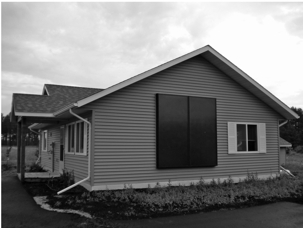
Εικόνα 3.1 Μια εγκατάσταση δύο επίπεδων ηλιακών συλλεκτών αέρα στη νότια πλευρά ενός κτιρίου στις ΗΠΑ.
