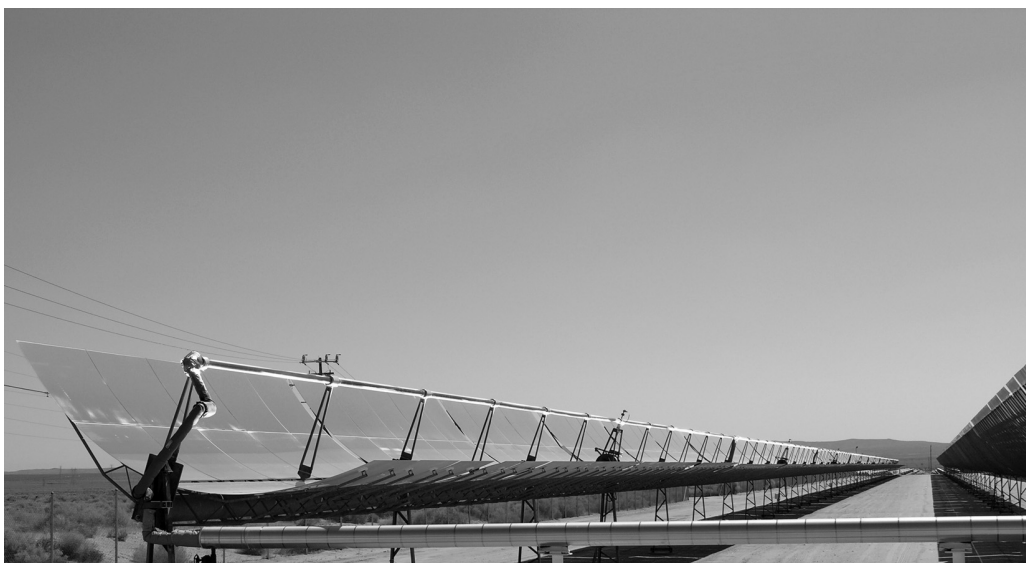
Εικόνα 3.3 Σύστημα παραβολικών κατόπτρων εστιακής γραμμής στο Kramer Junction (Καλιφόρνια ΗΠΑ).
