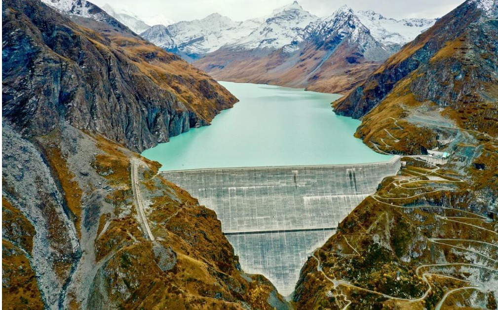
Εικόνα 7: Φράγμα βαρύτητας από σκυρόδεμα (Grande Dixence Dam, Switzerland)
