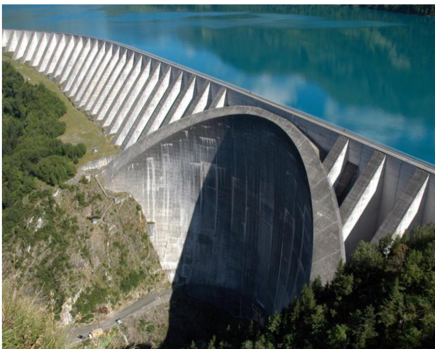
Εικόνα 10: Αντηριδωτό φράγμα/ buttress dam (Roselend Dam, France)
