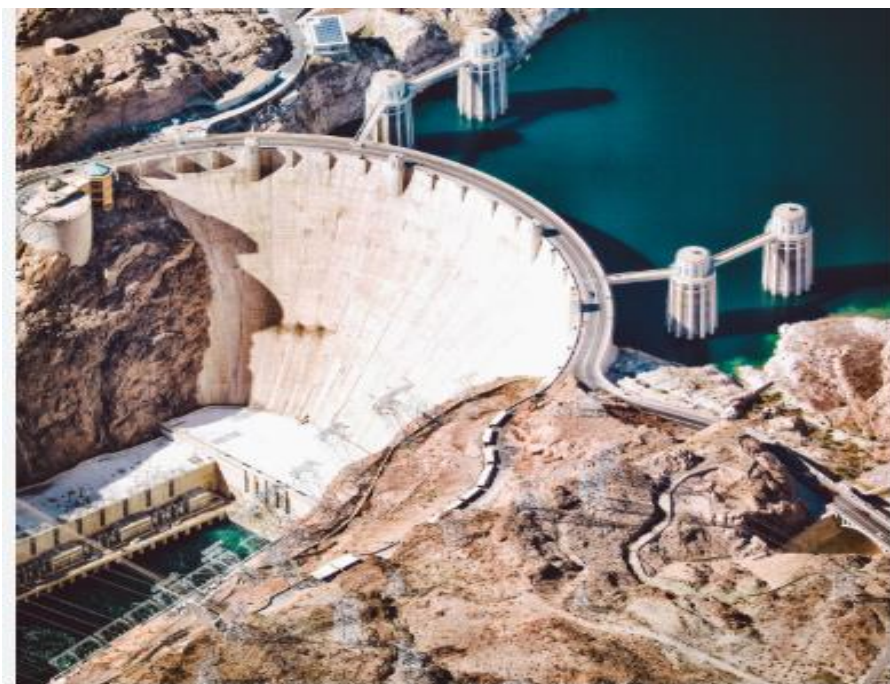
Εικόνα 9: Τοξωτό φράγμα / arched dam (Hoover Dam)
