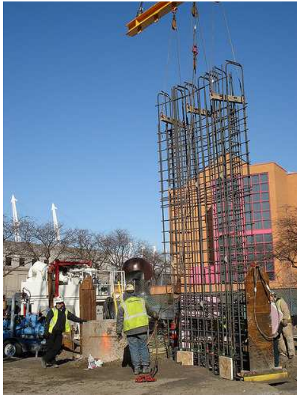
Εικόνα 8.5 Τοποθέτηση οπλισμού
