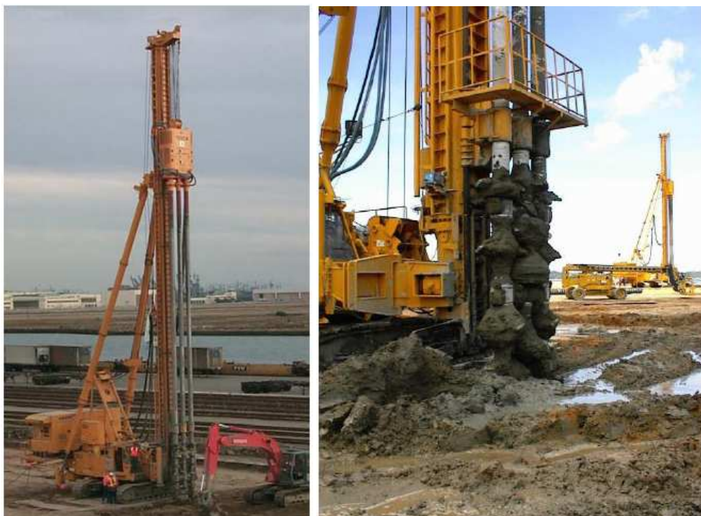
Εικόνα 8.12 Μηχανολογικός εξοπλισμός βαθιάς ανάμιξης εδάφους
