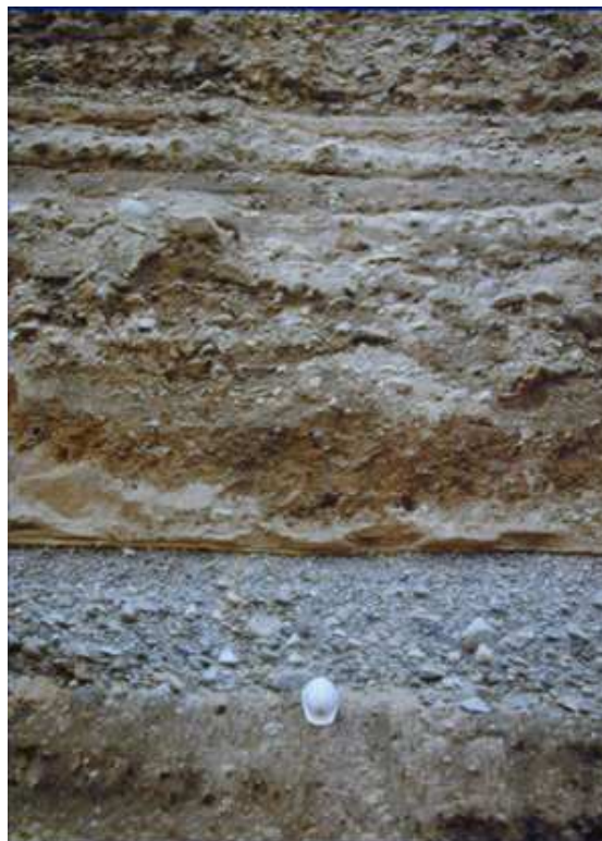
Εικόνα 4.1 Διαφοροποιήσεις υλικών καθ' ύψος, λόγω αποθέσεων ποταμού (Πηγή: http://mycourses.ntua.gr/courses/CIVIL1035/document.pdf )
