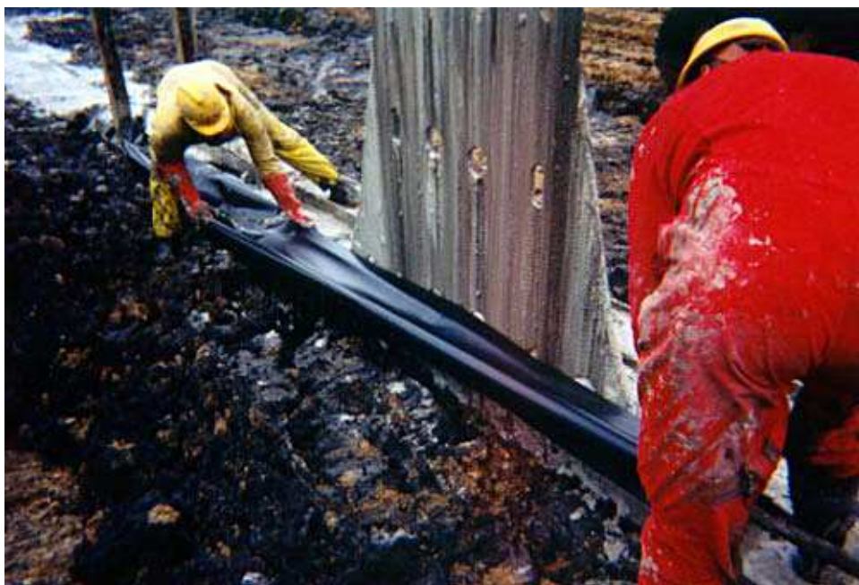
Εικόνα 8.8 Τοποθέτηση γεωμεμβράνης
