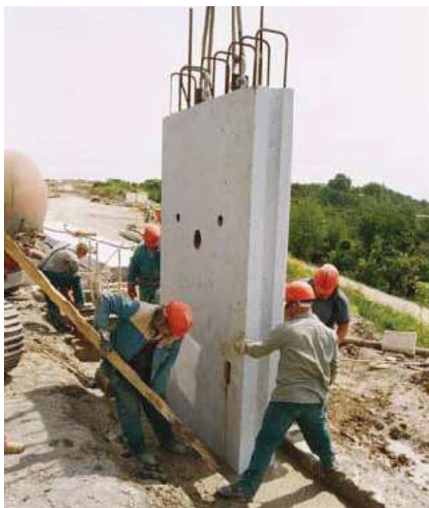
Εικόνα 8.7 Προκατασκευασμένο στοιχείο (Πηγή: http://www.zakladani.cz/download/web_technologie/3_podzemni_steny.pdf )
