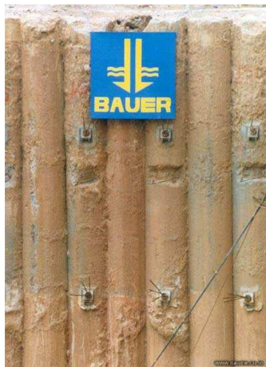
Εικόνα 8.9 Εικόνες κατά την κατασκευή διαφράγματος αλληλοτεμνόμενων πασσάλων (Πηγή: http://www.bauer.co.id/v2/links-secantpile.html και http://www.spolmik.org/downloads/seminars/Themeliotechniki.pdf )
