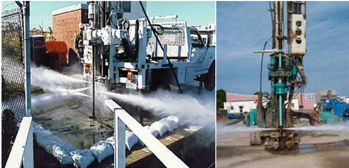
Εικόνα 8.14 Μηχανολογικός εξοπλισμός μεθόδου Jet Grouting
