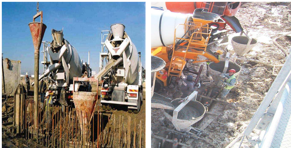
Εικόνα 8.6 Σωλήνες έγχυσης σκυροδέματος
