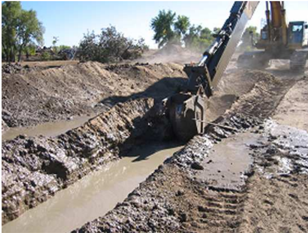
Σχήμα 8.11 Διάνοιξη τάφρου με χρήση εκσκαφέα με ανεστραμμένο πτύο (Πηγή: http://deereault.com/dam-reservoir-design/stagecoach-reservoir.php )
