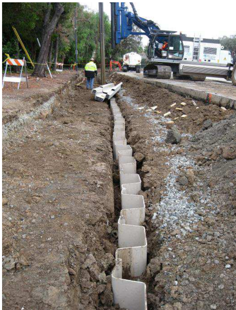
Εικόνα 8.10 Διάφραγμα με χρήση μεταλλικών πετασμάτων
