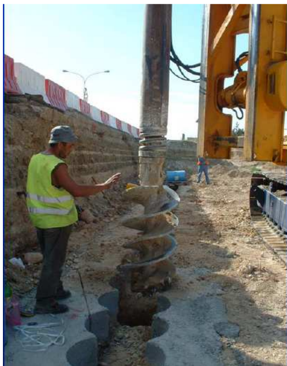
Εικόνα 8.9 Εικόνες κατά την κατασκευή διαφράγματος αλληλοτεμνόμενων πασσάλων (Πηγή: http://www.bauer.co.id/v2/links-secantpile.html και http://www.spolmik.org/downloads/seminars/Themeliotechniki.pdf )
