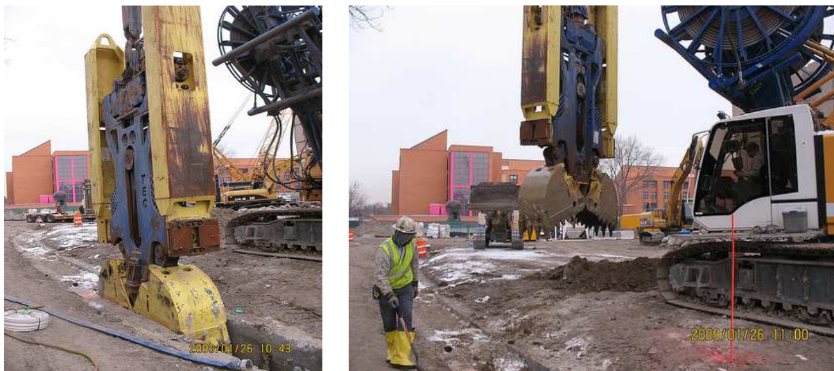
Εικόνα 8.2 Εκσκαφέας με αρπάγη για διάνοιξη τάφρου
